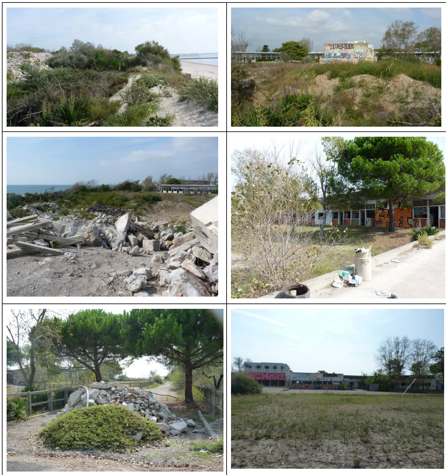
Figure 23 : Etat du site de l'ancien hôpital
